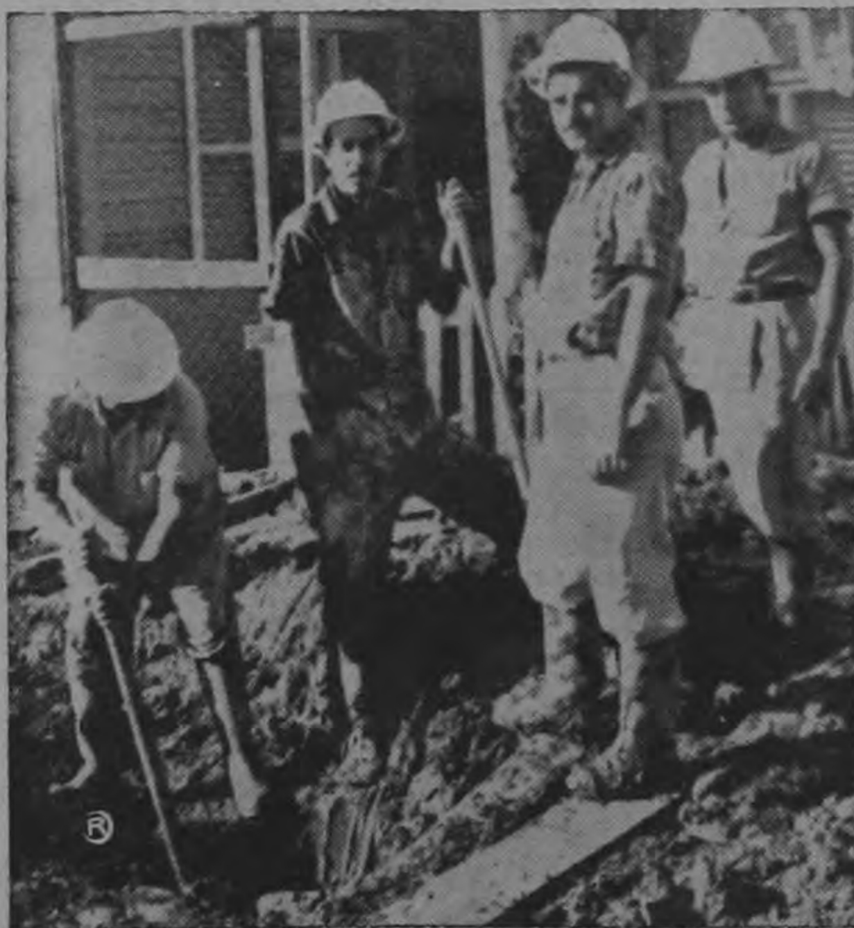
Una gran labor realiza el Instituto Costarricense de Electricidad, que ha mantenido su personal trabajando en jornada continua desde el martes en las primeras horas de la mañana, en el restablecimiento del servicio eléctrico.
